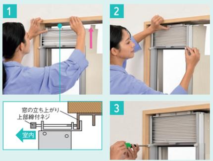
3 取付枠に窓ストッパーを取り付けます
