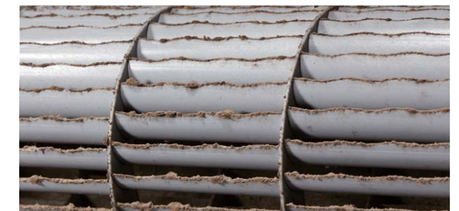
ホコリの溜まったファンの羽根先端部 (約2年間使用したエアコンの一例。使用状態や環境により異なります。)
